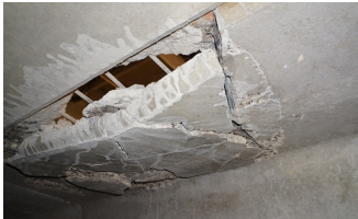
Fuente: Carrasquillo Associates
